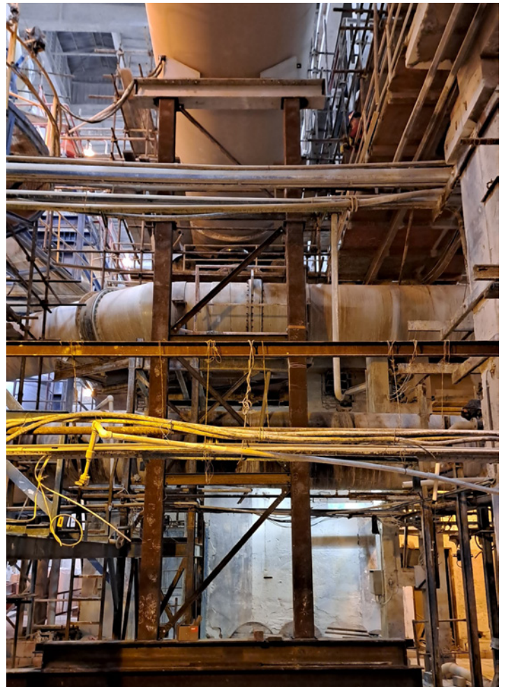
Podpěření kalcinační pece během opravy
