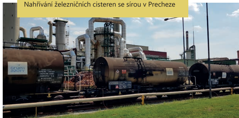
Nahlívací železničních cisteren se sírou v Precheze
