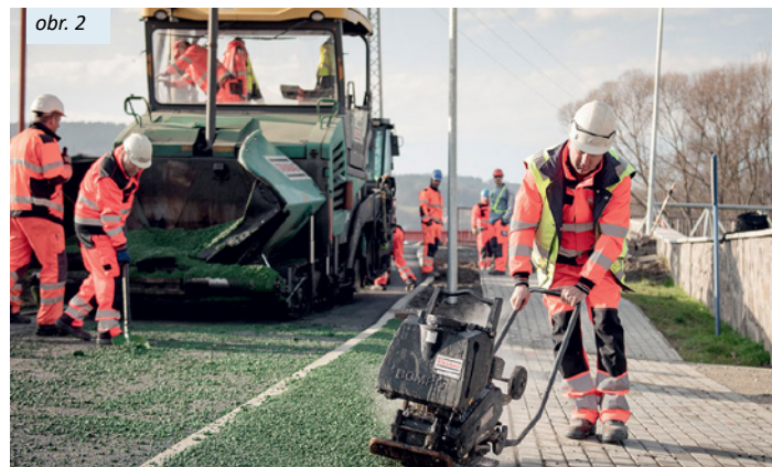
obr. 1 Detail barvy pojiva a válcového zkušebního tělesa zdroj: TPA Spoločnosť pre zabezpečenie kvality a inovácie s. r. o. obr. 2 Pokládka barevné obalované směsi zdroj: STRABAG s. r. o.
